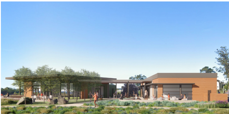
Mirando hacia el nuevo Centro Recreativo y Salón Comunitario.
